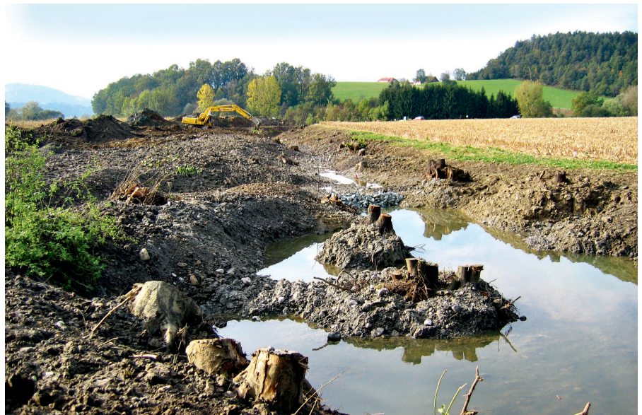
Abb. 2: Ersatz- und Ausgleichsmaßnahmen für die Störung oder Zerstörung von Lebensräumen sind in den Naturschutzgesetzen der Bundesländer unterschiedlich verankert. Foto: Sachgerecht gestaltetes Ersatzbiotop für Amphibien an einer Großbaustelle. © E.C.O., Michael Jungmeier
